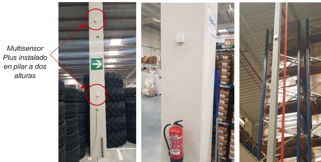
Figura 2. Multisensores instalados en los pilares a distintas alturas (1,8m y 7,5m)
