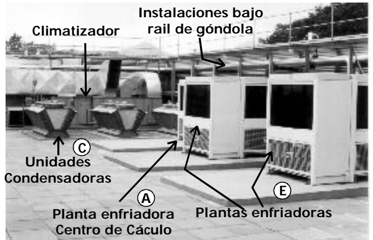
VISTA PARCIAL DE MAQUINARIA EN CUBIERTA
