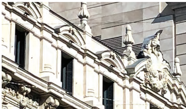
Vista integración arquitectónica de los exutorios de centro comercial en fachada de edificio.
