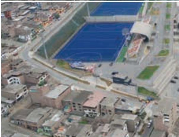
El Complejo Avelino Cáceres durante la ejecución de obra, y al final
